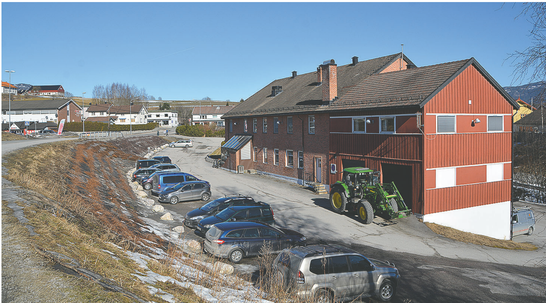
Endringar på Bekkevoll. Bekkevoll er i dag hovudbasen for teknisk eining i Bø kommune. Ein del av dei tilsette her må pendle til Ulefoss dersom det blir ein ny Midt-Telemarkkommune.
